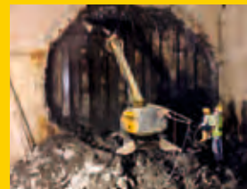
Ein sechs Meter tiefes Loch durch eine eineinhalb Meter dicke Stahlbetonwand.
