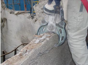
Schnell und effizient knackt die HCS 6 J Kombischere bis zu 15 Zentimeter starke Betonwände
