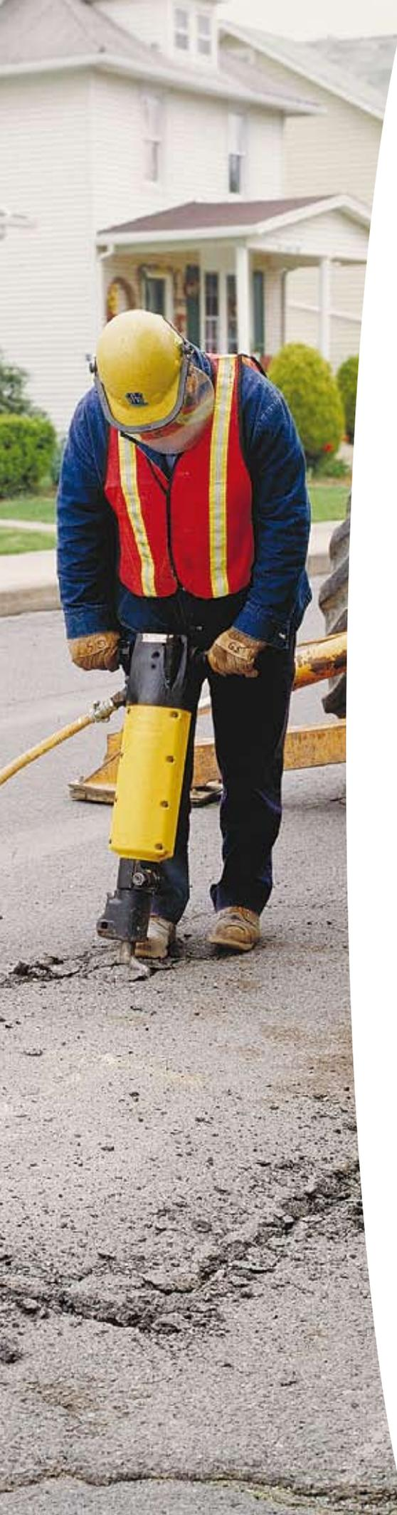
**Der schlank ausgeführte Schalldämpfer** drosselt den Geräuschpegel um bis zu 75 % (im Vergleich zu einer Maschine ohne Schalldämpfung, ISO 3744), ohne die freie Sicht auf den Meißel zu behindern.
