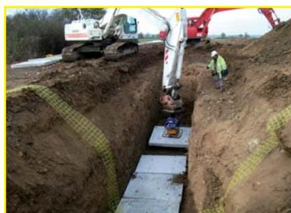
**SH-2500-UNI-B**, die maximale Freiheit für den Baggerfahrer. Mit Funkfernsteuerung und hydraulischem Drehknopf. So können Elemente ohne zusätzliche Hilfe sogar in Gefahrenbereichen verlegt werden
