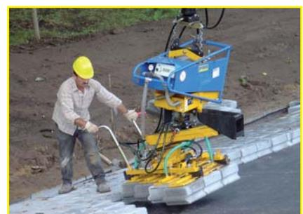
**SH-2500-UNI-B** mit Sonder-Mehrfachsaugplatte. Mit dieser Einheit werden 12 Uferwerksteine mit Vertikalverbund von der Palette abgenommen, zum Verlegeverband verschoben, der Böschungsneigung angepasst und verlegt
