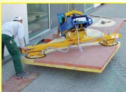
**SH-2500-UNI-B**, mit Traverse TRA-3000 für die Verlegung von mehrfarbigen Sonderplatten (ca. 2 x 2 m)
