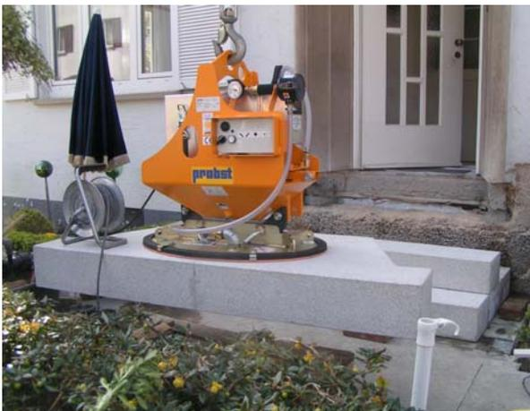
Problemloses Versetzen von 2 Betonwerkstein-Stufen (Abmaße ca. 168x32x17cm Gewicht ca. 220 kg) mit dem **Vakuumbegerät SH 1000 mini eW** mit einer max. Tragfähigkeit von max. 1000 kg (Abhängig von der Größe der Sauplatte).
