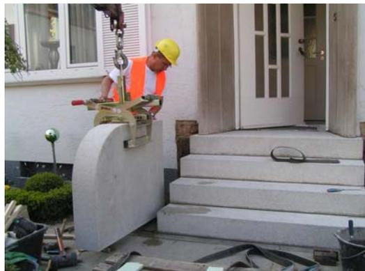
Die Verlegung der Treppenwangen erfolgt problemlos mit der universell einsetzbaren **Trittstufen-Versetzzange TSZ-uni** mit der u. a. Elemente mit einer Breite von 570 mm und einem max. Gewicht von 500 kg versetzt werden können
