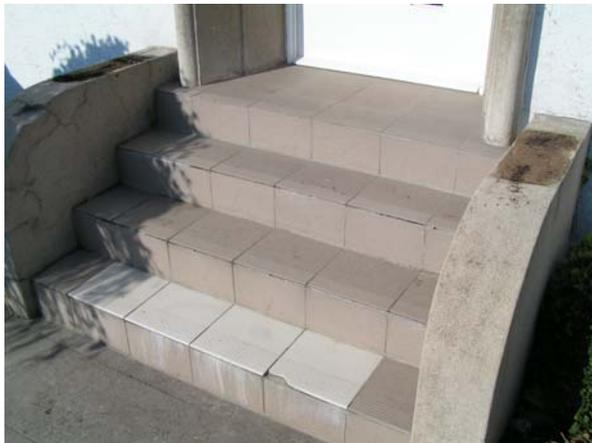
Alte schon mehrfach restaurierte Treppe, teilweise mit Steingut-Fliesen belegt. Diese wurde weggespitzt und u. a. mit der **Trittstufen-Versetzzange TSZ-uni** abgebaut.
