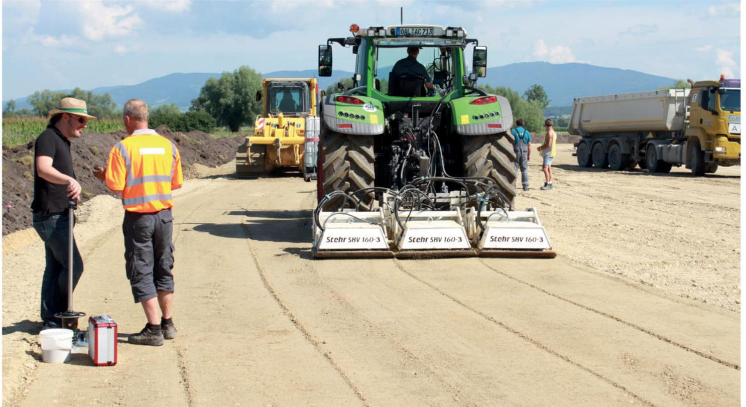
Die neuen, Europapatentierten Stehr-Verdichterplatten SBV 160-3 mit 100% gerichteten Schwingungen und einer Vibrationsfrequenz von 70 Hz sind in der Verdichtung von o.g. Böden jedem Walzenzug überlegen.
