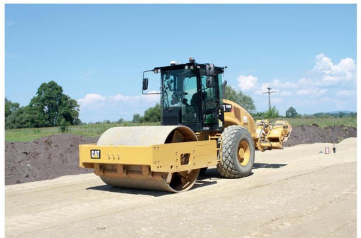
Durch die Hochfrequenz-Verdichtung von 70 Hz werden die einzelnen Körner doppelt so schnell angeregt und verlagern sich in die Hohlräume zwischen den größeren Körnern, was zu einer schnelleren und effektiveren Endverdichtung führt. Zudem wird bei dieser Verdichtungsmethode die Umwelt nachhaltig entlastet. Es werden bis zu 50% Kraftstoff eingespart, die CO2 Emissionen werden wesentlich verringert, und es ergeben sich signifikante Produktivitätssteigerungen bei der Verdichtung.
