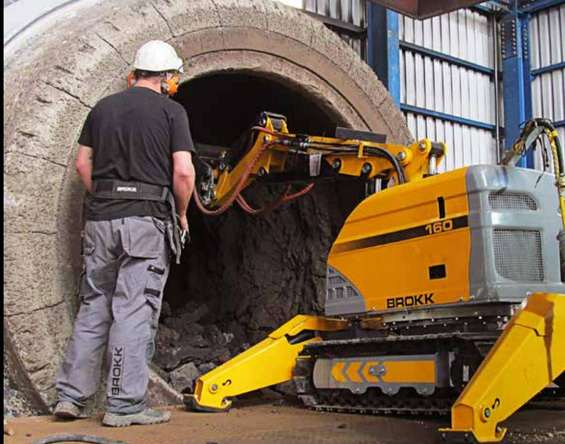
Ausbruch des Ansatzes. **Brokk 90** mit Hydraulikhammer SB302.
