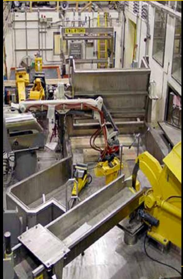
**Brokk 330** mit Hydraulikhammer zerlegt eine heiße Zelle hinter Acrylglas.
