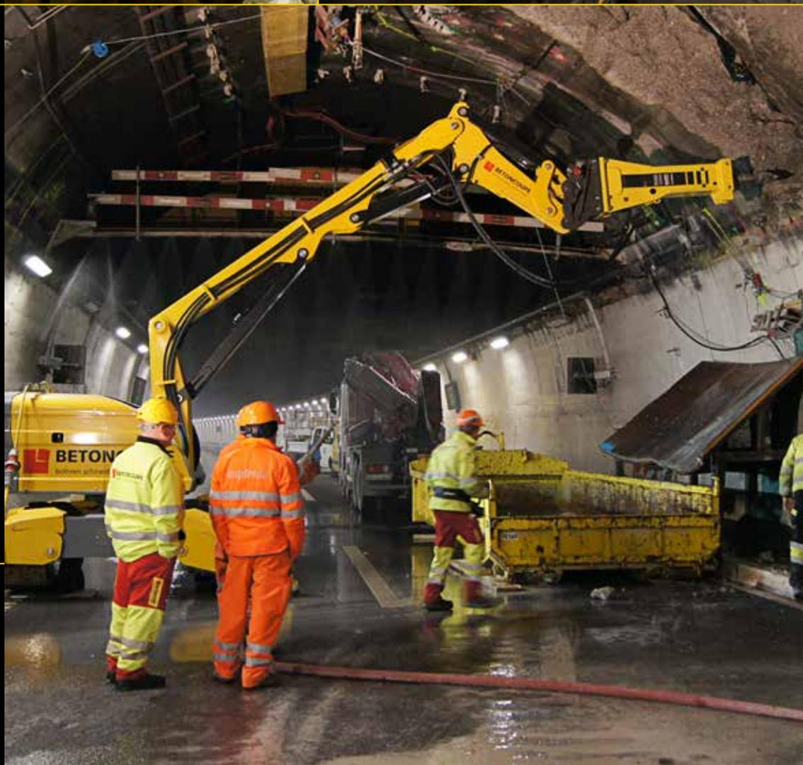
**Brokk 160** mit Hydraulikhammer bei der Erstellung von Querschlägen in Doha, Katar.
