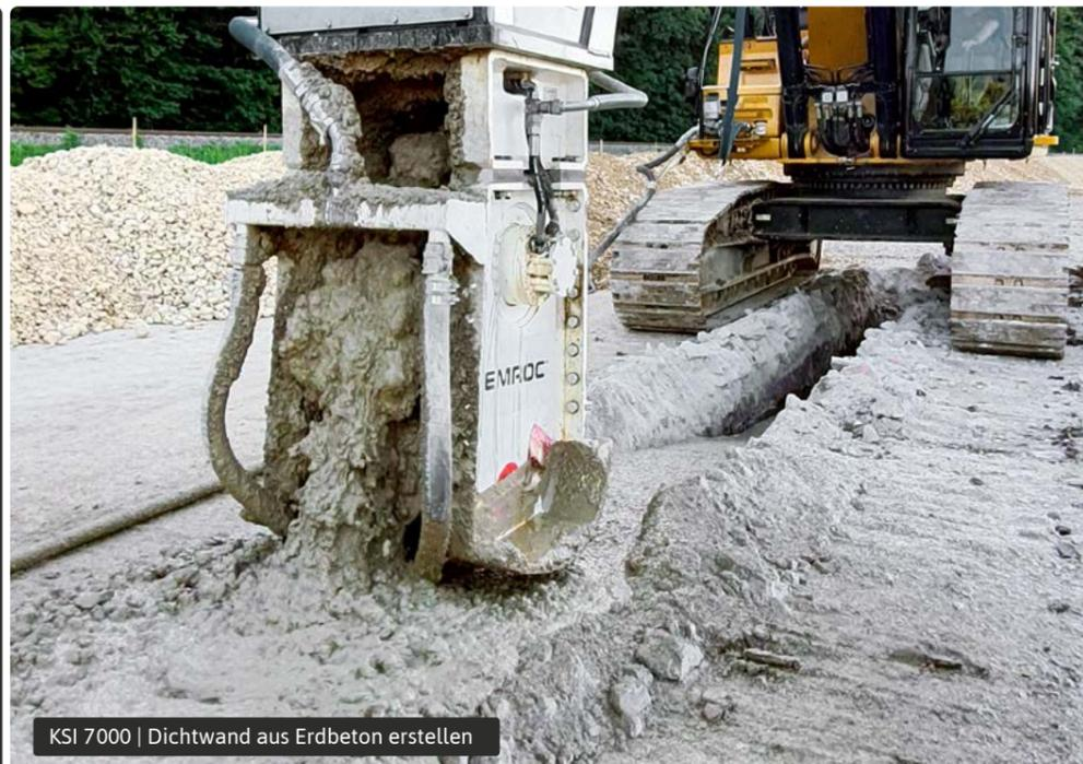
KSI 7000 | Dichtwand aus Erdbeton erstellen
