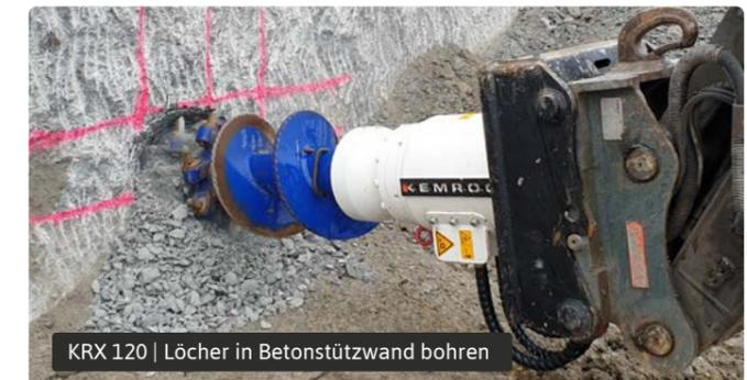
KRX 120 | Löcher in Betonstützwand bohren
