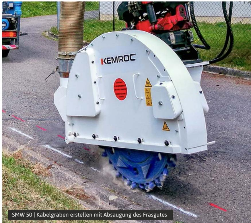
SMW 50 | Kabelgräben erstellen mit Absaugung des Fräsgutes
