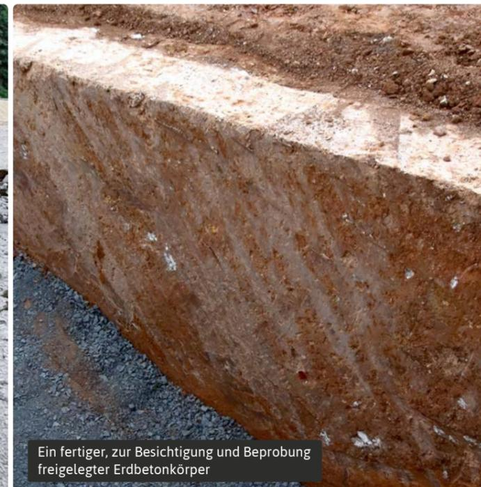
Ein fertiger, zur Besichtigung und Beprobung freigelegter Erdbetonkörper
